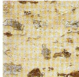
Les joints doivent être bien pleins et exécutés à fleur de parement ; ils pourront être lissés (joints beurrés à l'ancienne), brossés ou grattés, selon l'aspect recherché. Ces finitions s'obtiennent plus aisément avec des mortiers de chaux qu'avec des mortiers de plâtre.
